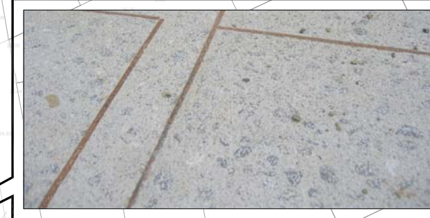
HORMIGON ABUJARDADO CON LLANTAS SIN JUNTA VERDE
