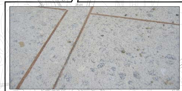
HORMIGON ABUJARDADO CON LLANTAS SIN JUNTA VERDE
