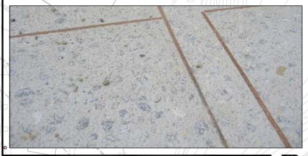
HORMIGON ABUJARDADO CON LLANTAS SIN JUNTA VERDE
