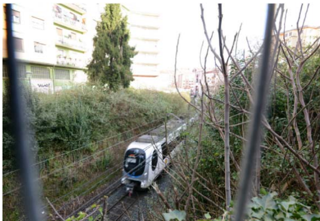
Imagen 15. Desnivel abrupto junto a la vía del tren. Fuente: Elaboración propia
