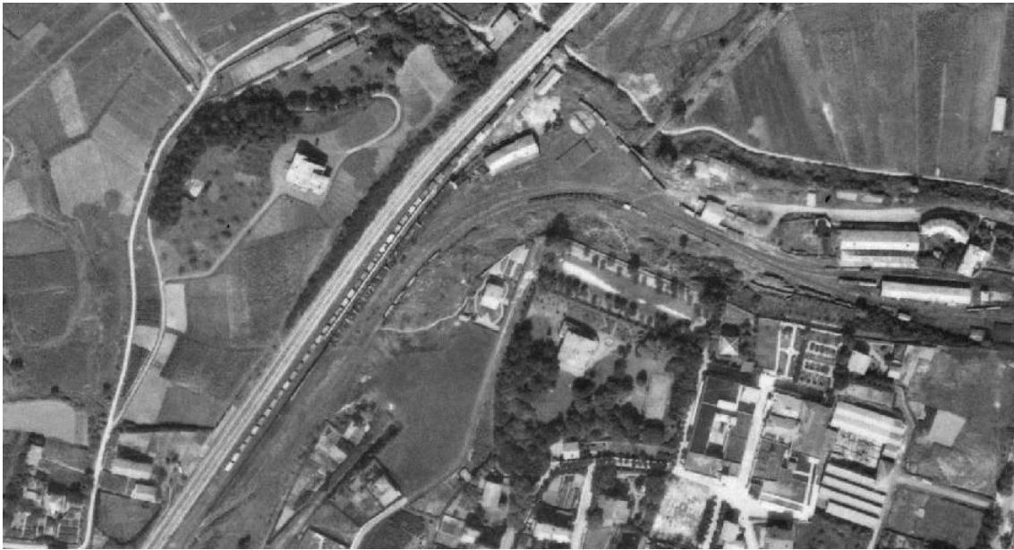
Ortofoto de 1954. Se aprecia la edificación existente en aquella época
