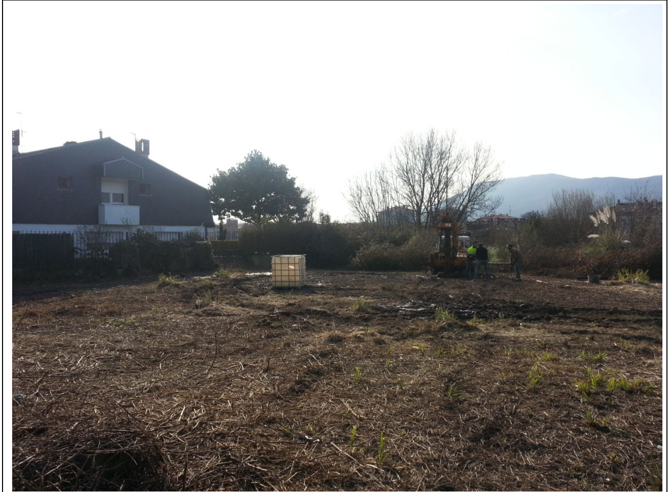
Emplazamiento del sondeo S-3 ( Foto 7 , sup)
