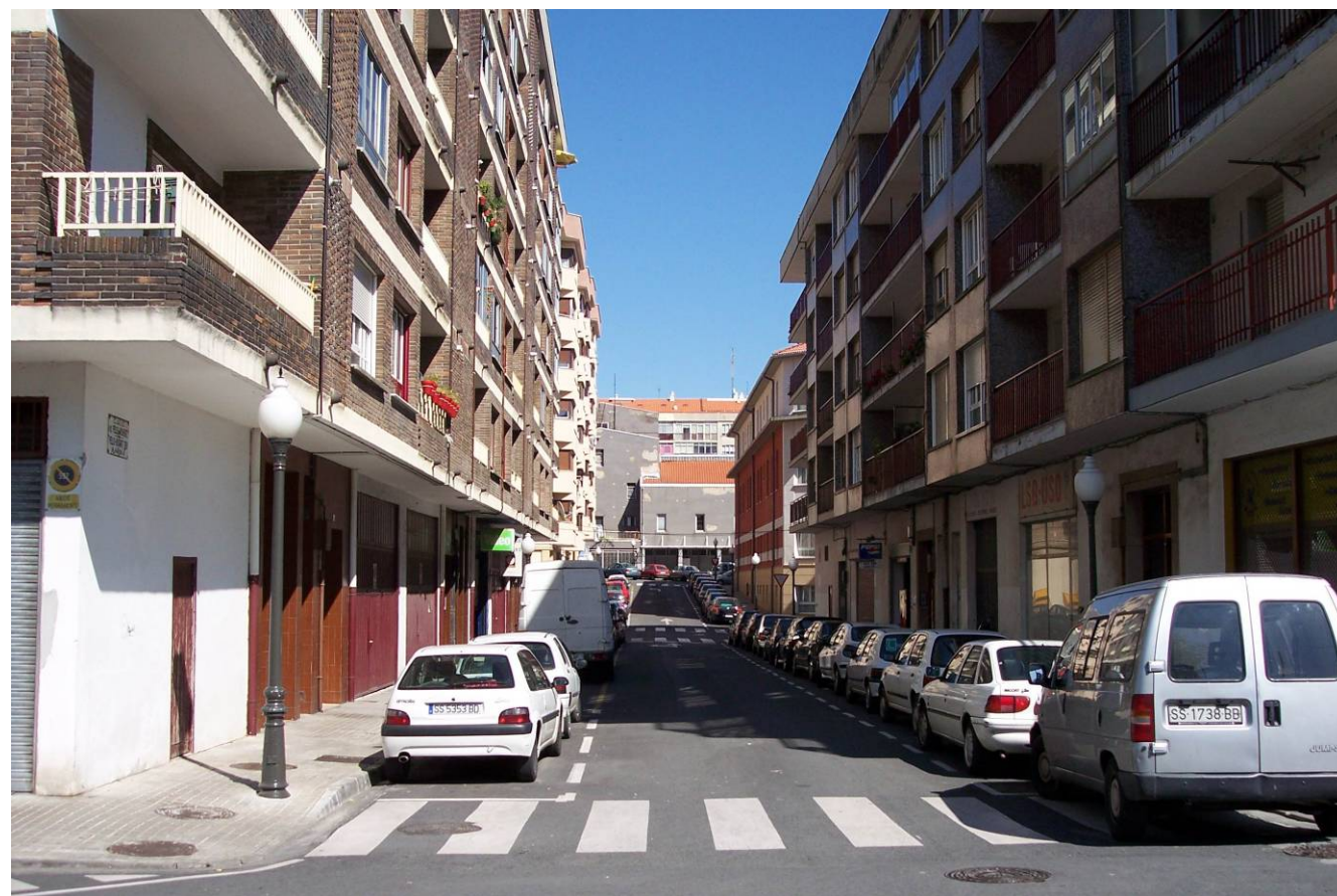
Calle Pello Bixente con el equipamiento al fondo.
