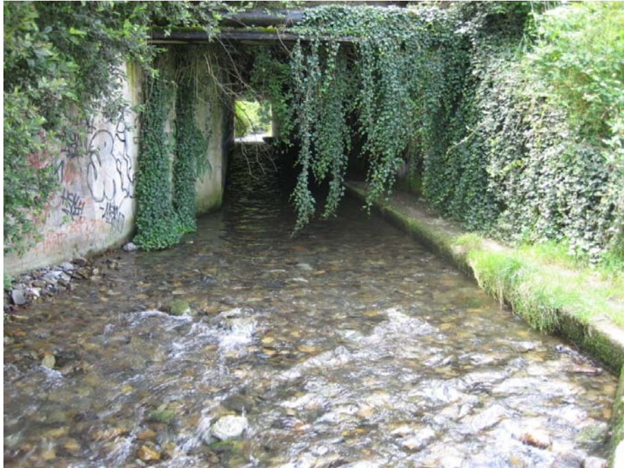
SECCIÓN 22: Cauce compuesto por grava y roca, no tiene irregularidades en el lecho pero sí cambios ocasionales transversalmente. No existen obstrucciones y no hay vegetación dentro del cauce del río.
