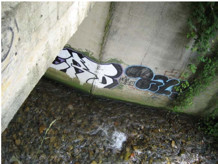
SECCIÓN 23: Cauce compuesto por grava y roca, no tiene irregularidades en el lecho pero sí cambios ocasionales transversalmente. No existen obstrucciones y no hay vegetación dentro del cauce del río.
