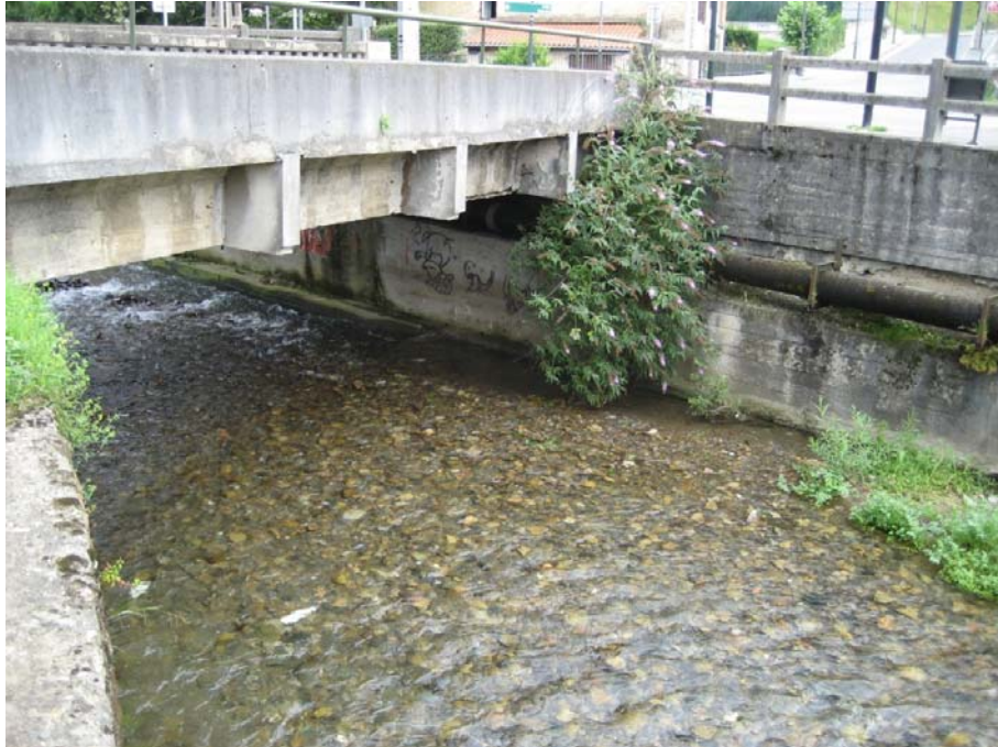
SECCIÓN 17: Cauce compuesto por grava y roca, tiene pequeñas irregularidades en el lecho y también cambios ocasionales transversalmente. No existen obstrucciones y la vegetación dentro del cauce del río es media.
