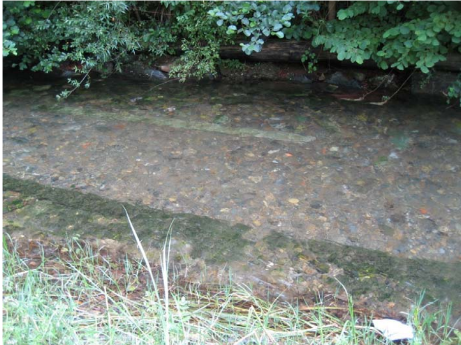
SECCIÓN 9: Cauce compuesto por grava y roca, no tiene irregularidades y tampoco cambios transversales. No existen obstrucciones y la vegetación dentro del cauce del río es media.
