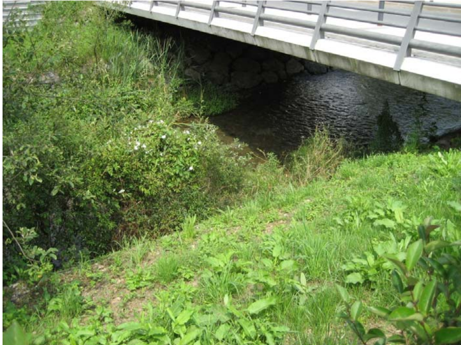
SECCIÓN 13: Cauce compuesto por grava y roca, no tiene irregularidades y tampoco cambios transversales. No existen obstrucciones y la vegetación dentro del cauce del río es media.
