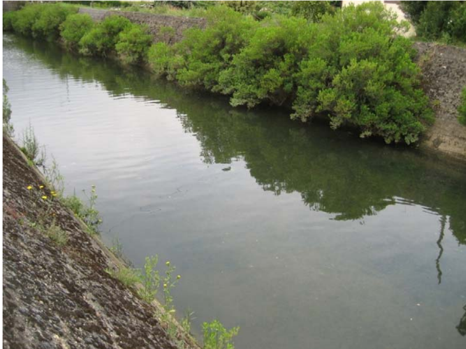
SECCIÓN 5: Compuesta por grava y roca, no tiene irregularidades y tampoco cambios transversales. No existen obstrucciones y la vegetación dentro del cauce del río es bastante escasa.
