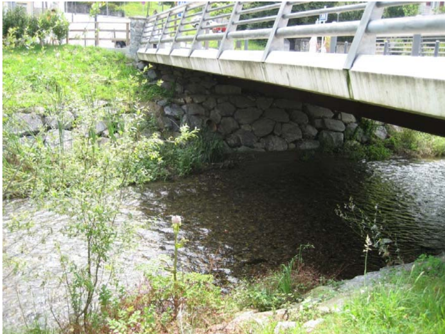
SECCIÓN 12: Cauce compuesto por grava y roca, no tiene irregularidades y tampoco cambios transversales. No existen obstrucciones y la vegetación dentro del cauce del río es media.
