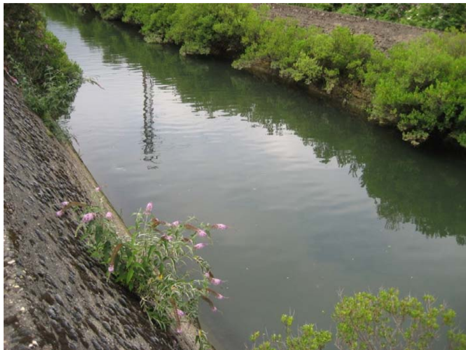
SECCIÓN 4: Compuesta por grava y roca, no tiene irregularidades y tampoco cambios transversales. No existen obstrucciones y la vegetación dentro del cauce del río es bastante escasa.
