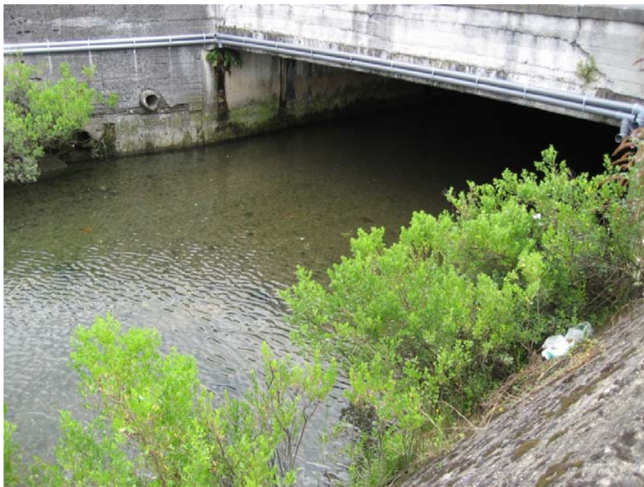
SECCIÓN 6: Compuesta por grava y roca, no tiene irregularidades y tampoco cambios transversales. No existen obstrucciones y la vegetación dentro del cauce del río es bastante escasa.
