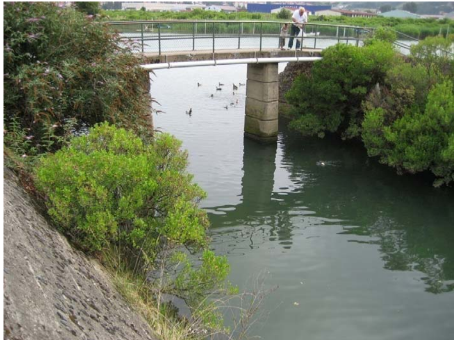
SECCIÓN 2: Compuesta por grava y roca, no tiene irregularidades y tampoco cambios transversales. No existen obstrucciones y la vegetación dentro del cauce del río es bastante escasa.
