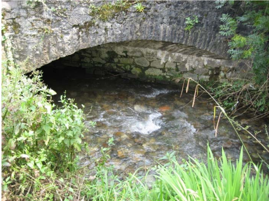
SECCIÓN 28: Cauce compuesto por grava y roca, tiene irregularidades despreciables en el lecho y también cambios ocasionales transversalmente. No existen obstrucciones y la vegetación dentro del cauce del río es media.
