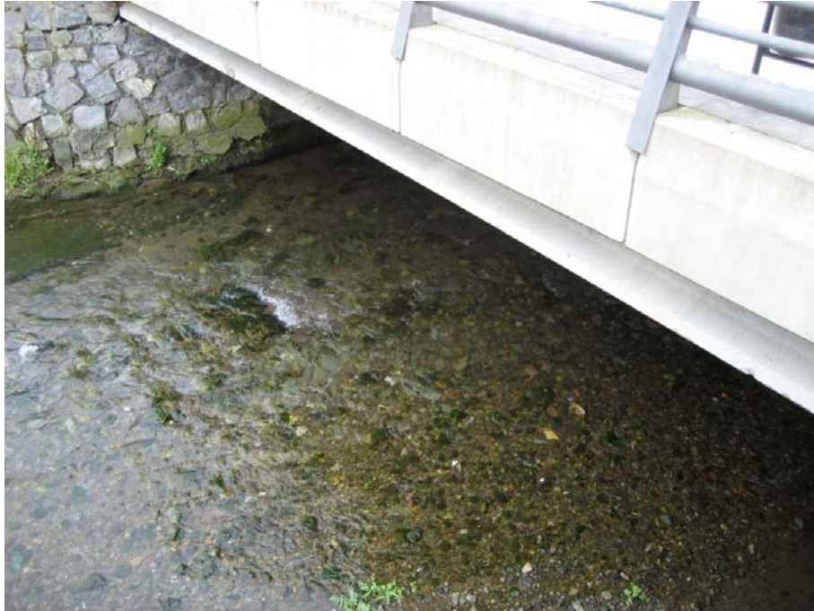
SECCIÓN 7: Compuesta por grava y roca, no tiene irregularidades y tampoco cambios transversales. No existen obstrucciones y la vegetación dentro del cauce del río es bastante escasa.
