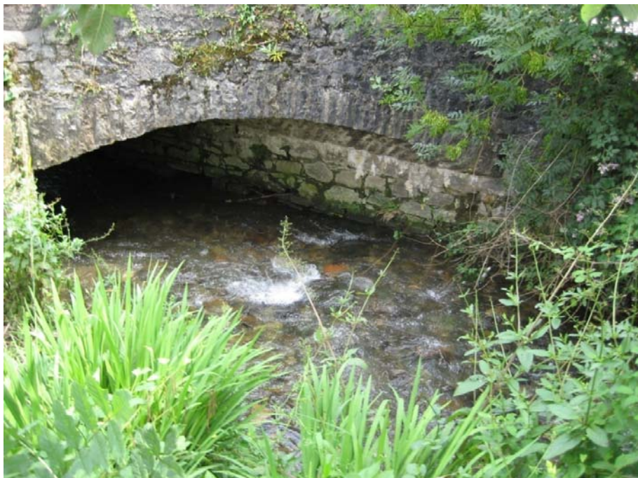
SECCIÓN 29: Cauce compuesto por grava y roca, tiene irregularidades despreciables en el lecho y también cambios ocasionales transversalmente. No existen obstrucciones y la vegetación dentro del cauce del río es media.
