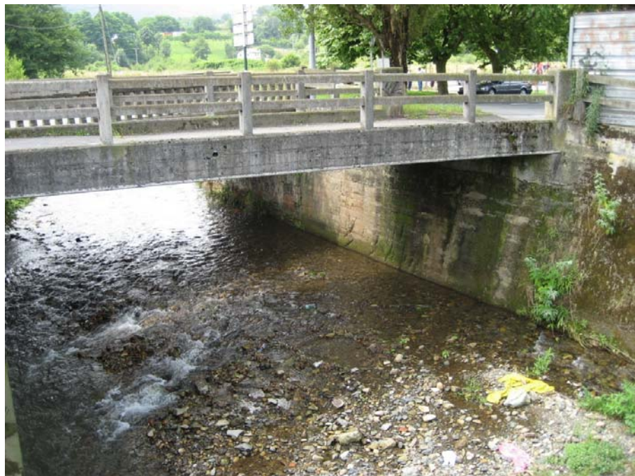
SECCIÓN 16: Cauce compuesto por grava y roca, tiene pequeñas irregularidades en el lecho y también cambios ocasionales transversalmente. No existen obstrucciones y la vegetación dentro del cauce del río es media.
